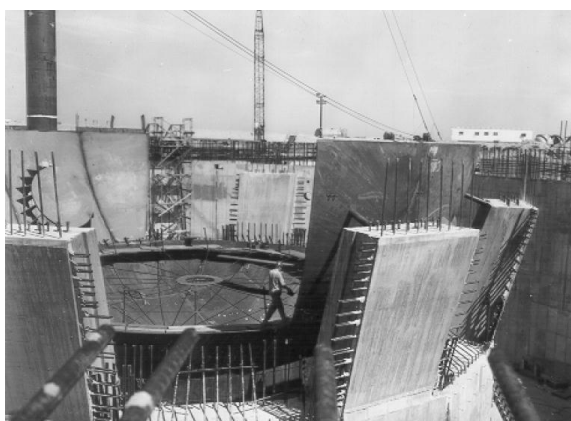
Figura 6. Fotografia di una fase della costruzione delle pareti di cemento armato del contenimento primario di tipo Mark-I presso la centrale di Pilgrim Station.
