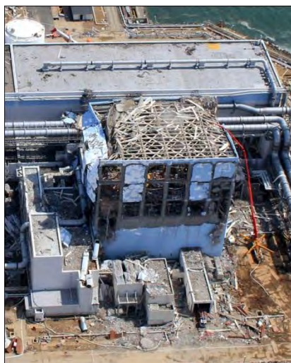
Figura 60. Operazioni di versamento di acqua sugli elementi della piscina di stoccaggio del combustibile esaurito dell'unità 4 per mezzo di un camion per la posa del cemento.
