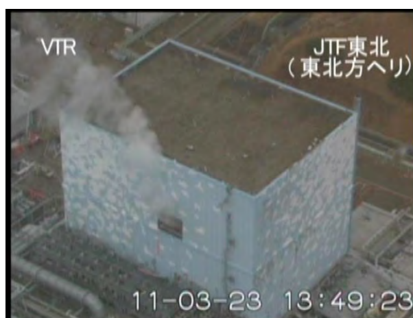
Figura 41. Apertura di alcuni pannelli nella parte sacrificale dell'edificio reattore dell'unità 2.
