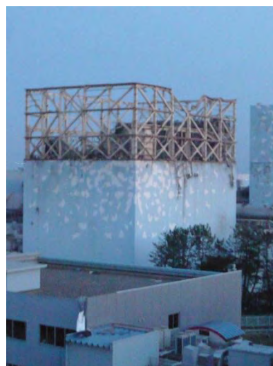
Figura 36. Esplosione di Idrogeno all'interno dell'edificio reattore dell'unità 1 (sinistra) e dettaglio dello stato dell'edificio dopo l'esplosione (destra).
