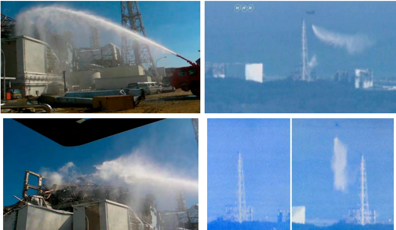
Figura 59. Immagini delle operazioni di spray di acqua sull'edificio dell'unità 3 per riversare acqua sugli elementi di combustibile esauriti.
