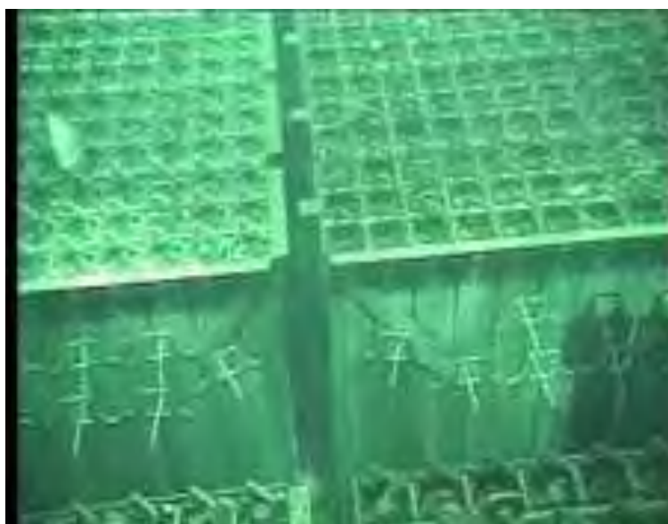
Figura 51. Stato del combustibile nella piscina di stoccaggio dell'unità 4 dopo l'esplosione.
