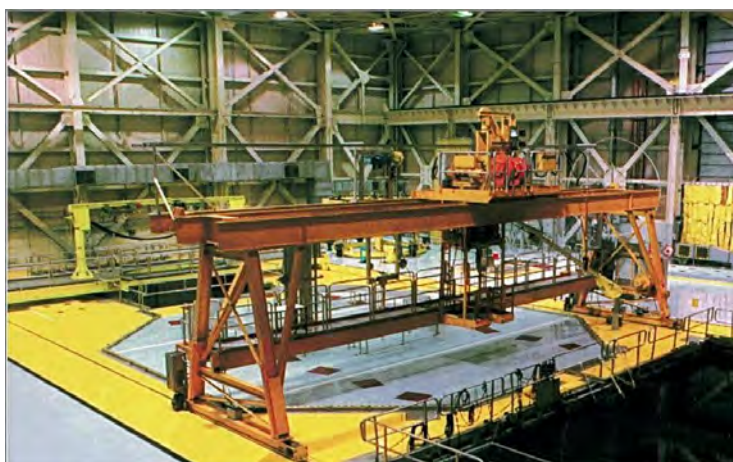
Figura 12. Vista del piano servizio dell'edificio reattore e, sullo sfondo, la struttura sacrificale delle pareti.
