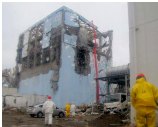
Figura 60. Operazioni di versamento di acqua sugli elementi della piscina di stoccaggio del combustibile esaurito dell'unità 4 per mezzo di un camion per la posa del cemento.
