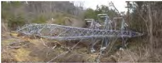
Figura 29. Dettagli dei danneggiamenti alle linee elettriche che connettono il sito di Fukushima-Dai-ichi alla rete elettrica nazionale giapponese.
