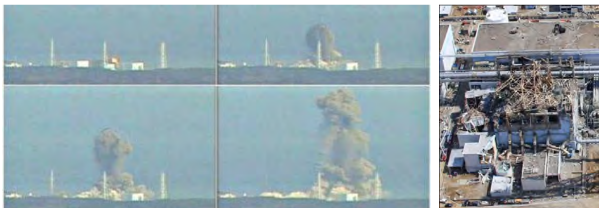
Figura 46. Istantanee dell'esplosione di Idrogeno avvenuta nell'unità 3, e condizione dell'edificio reattore dopo l'evento.
