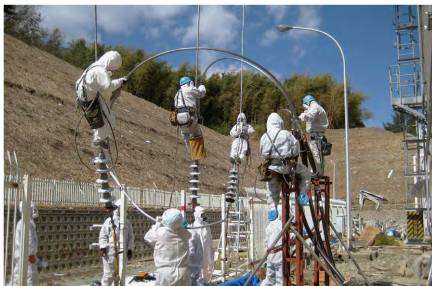
Figura 53. Operai della TEPCO lavorano al ripristino dell'alimentazione elettrica esterna al sito.
