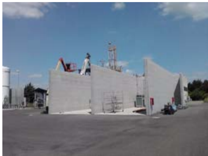
Figura 2 Vista Bunker di stoccaggio Idrogeno
