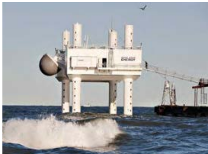
Figura 1.8 – A sinistra: Dispositivo WaveStar in scala ridotta fase preliminare in mare a Nissum Bredning; A destra: stesso dispositivo in scala reale a Hanstholm (Danimarca)
