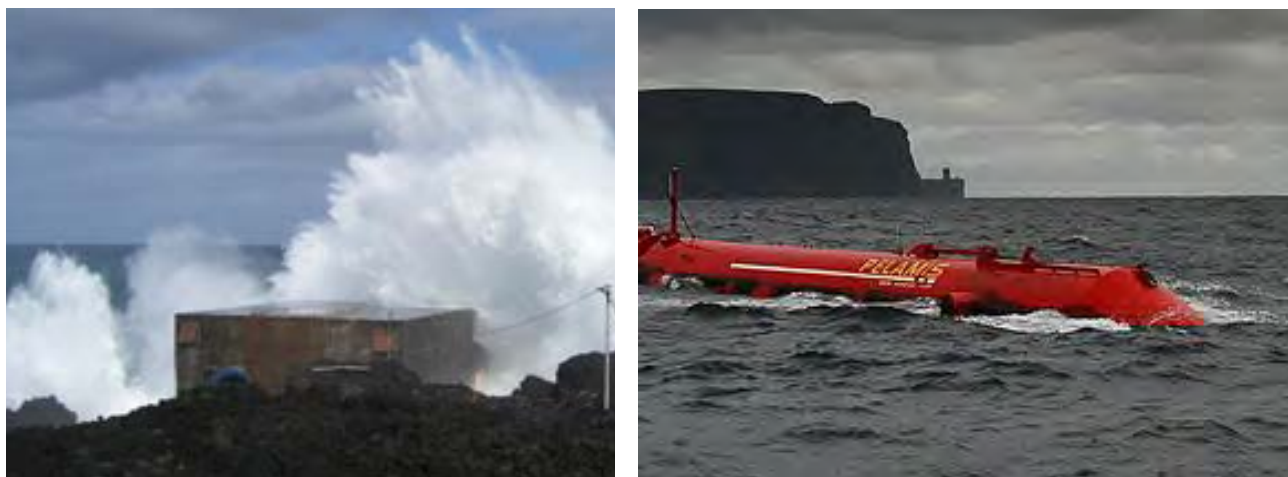
Figura 1.7 – A sinistra: Dispositivo PICO (Azzorre- PT); A destra: Dispositivo PELAMIS (test 2008, Agucadoura - PT)
