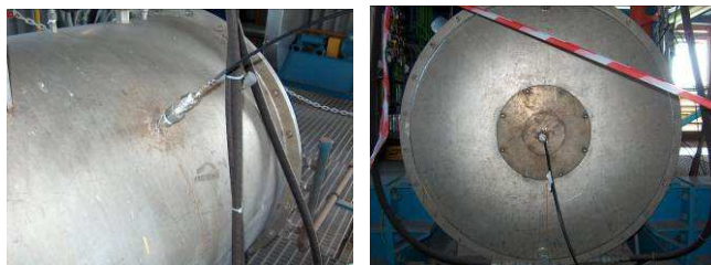
Figura 2 Camera di combustione, posizione sonda radiale e assiale
