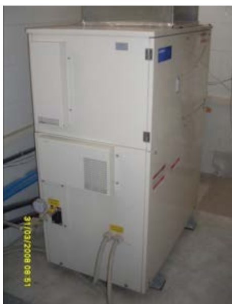
Figura 7. Microcogeneratore
