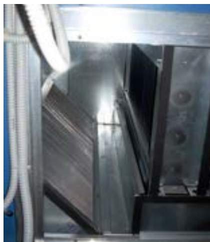
Figura 4. Scambiatore a flussi incrociati
