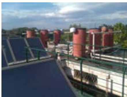
Fig. 15 – Impianto solare a collettori piani.
