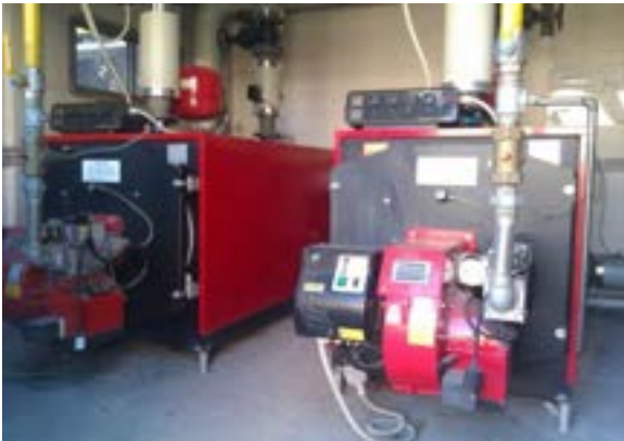
Fig. 3 – Caldaie esistenti da 350 kW th , ciascuna
