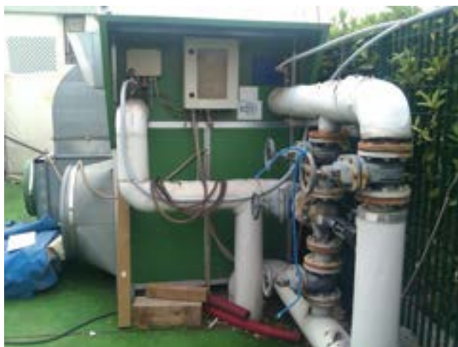
Fig. 25 – Termoventilante Piscina.
