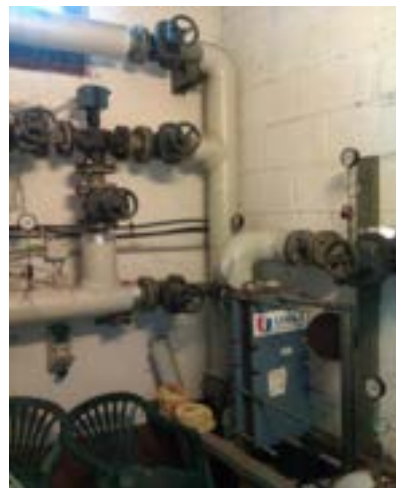
Fig. 26 – Scambiatore Acqua/Acqua.
