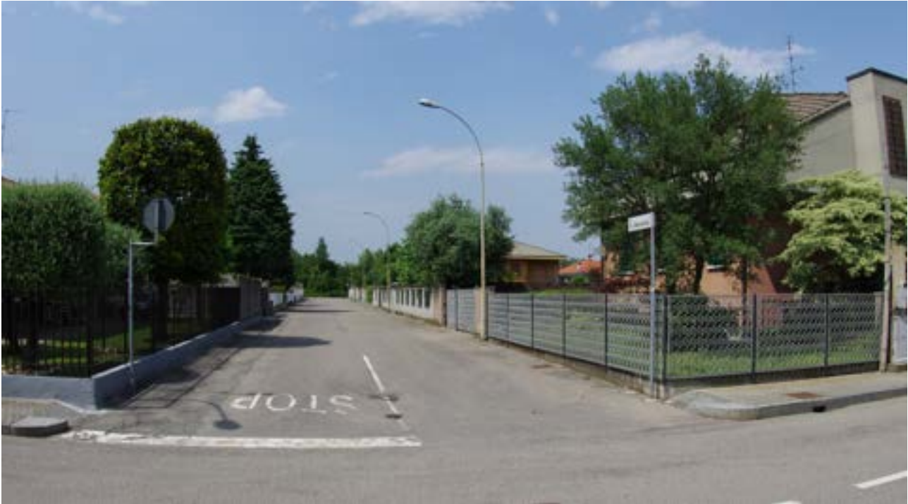
Figura 4 Strada e impianto di illuminazione presente nel sito originariamente previsto per le prove di impianti di tipo urbano.
