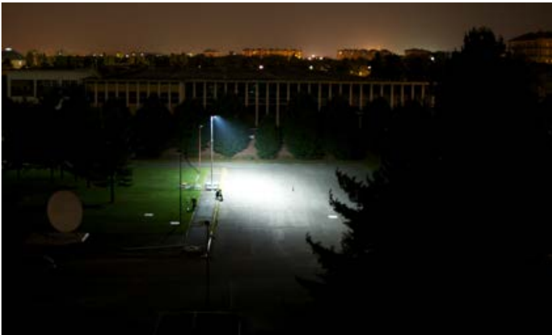
Figura 68 Impianto con apparecchio con vetro piano e con sorgenti LED – primo esempio di acquisizione dall'alto – immagine fotografica.
