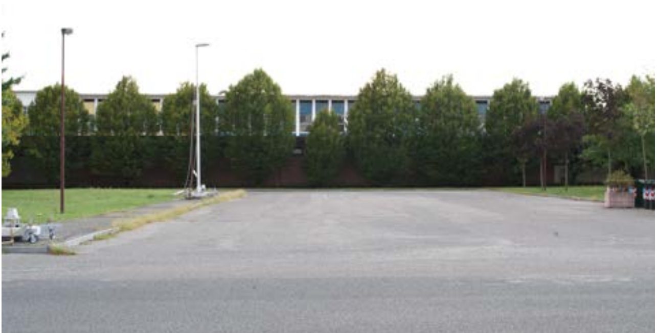
Figura 6 Strada e impianto di illuminazione presente nel sito scelto presso la sede INRIM (Il primo palo a sinistra appartiene all'impianto fisso INRIM, spento durante le prove, il secondo è quello sperimentale).
