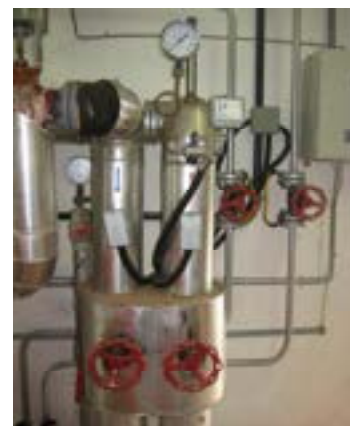
Figura 27: Scambiatore di calore in centrale termica
