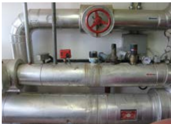
Figura 27: Scambiatore di calore in centrale termica
