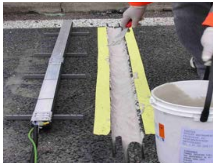
Figura 6 – Installazione di una piastra piezoelettrica al quarzo.
