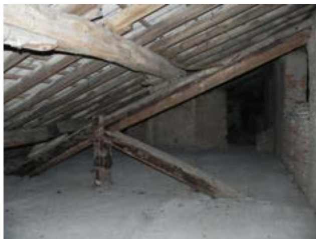
fig. 3.6.2 Immagini della copertura dell'Ala Sud. Un dettaglio del manto di coppi e del canale di gronda (a sinistra); un'immagine del sottotetto (in alto).
