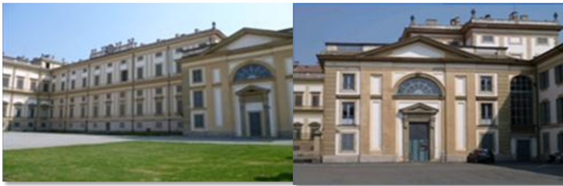
fig. 3.3.1 L'ala sud: il suo prospetto nord (a sinistra) e la cavallerizza (a destra), situata ad est rispetto al corpo dell'ala sud
