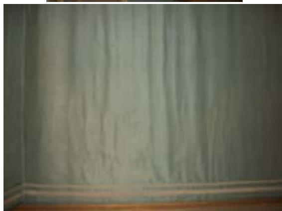
Fig. 9. Zona sotto il pannello mobile
