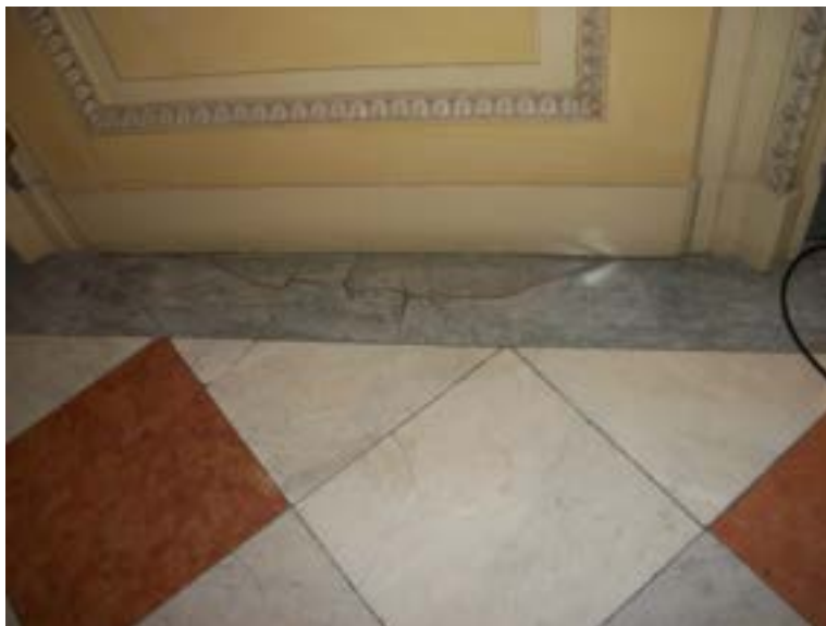
Fig. 16. Particolare del corridoio in materiale lapideo
