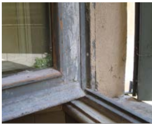
fig. 3.6.1 Una finestra della Villa Reale ed un suo dettaglio. Le dimensioni del telaio sono idonee all'inserimento di un doppio vetro
