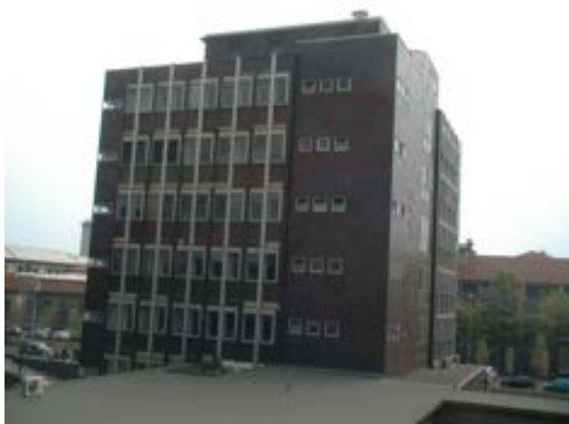
Figura 2. Foto della facciata Nord dell'edificio in esame.
