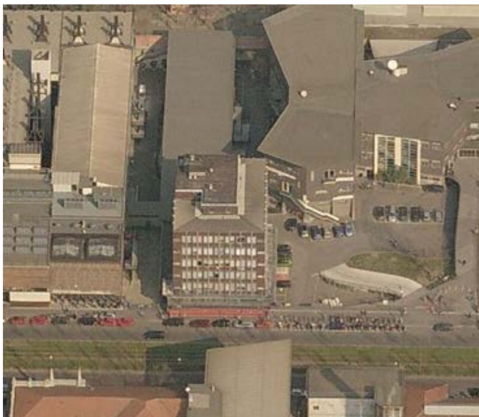
Figura 3. Foto aerea dell'edificio inserito nel contesto del Campus Leonardo lungo Via Bonardi.
