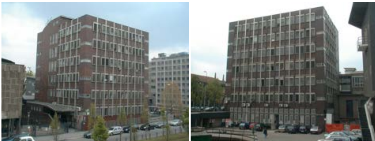
Figura 1. Foto delle facciate Sud e Ovest (a sinistra) e della facciata Est (sinistra) dell'edificio in esame.
