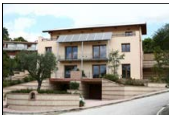
Fig. 1 - Facciata sud della LH
