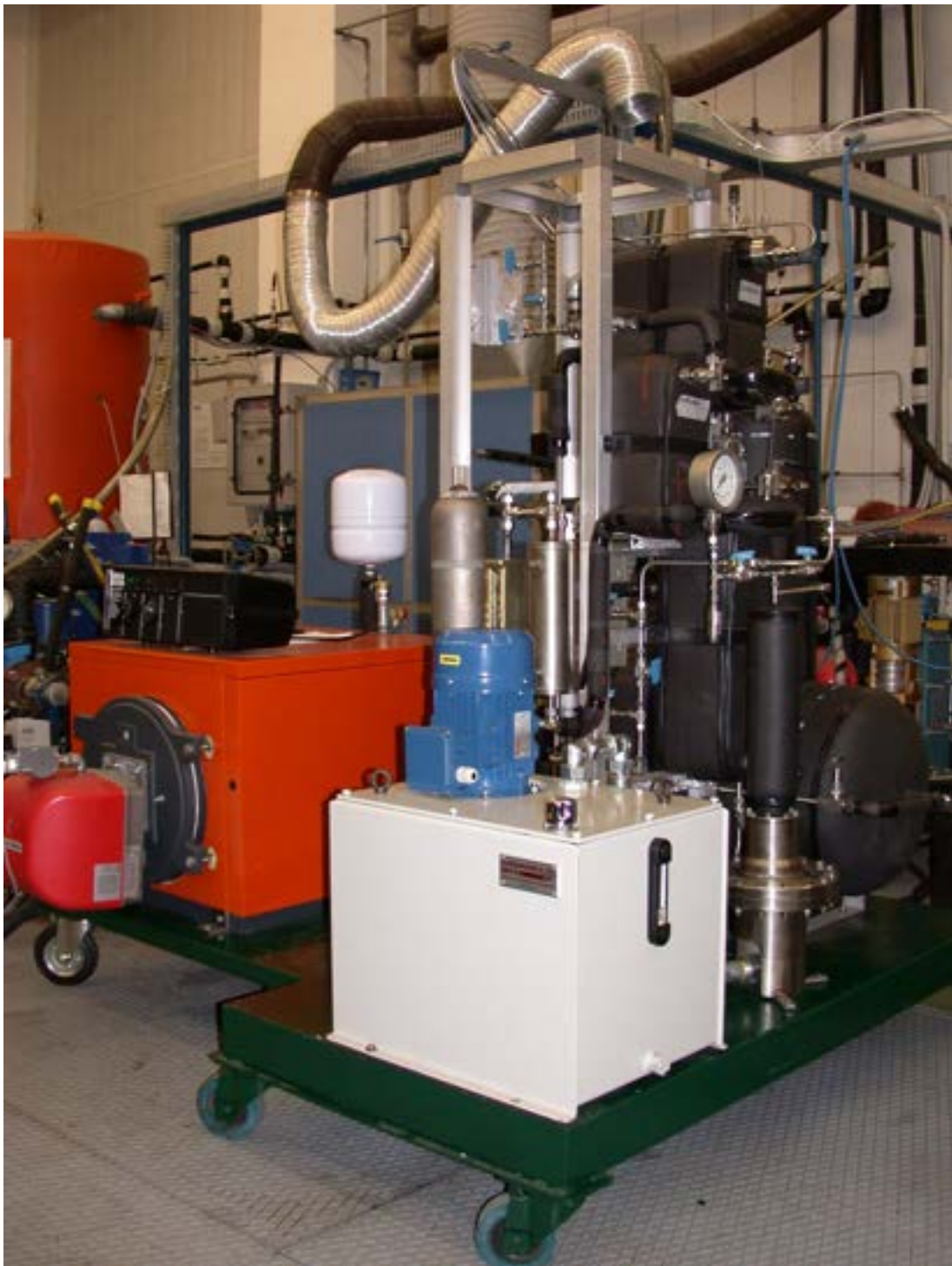
Figura 11 – Il prototipo ENEA da 18 kW: installazione ultimata
