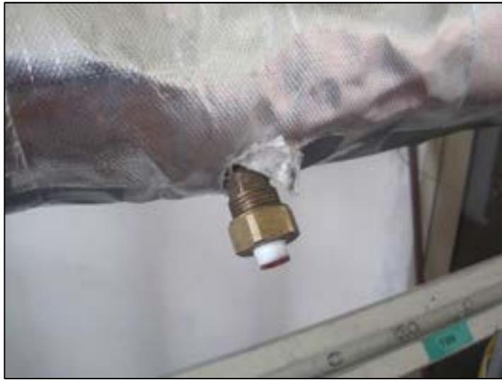
Fig. 3.4: Dado di innesto sul collettore
