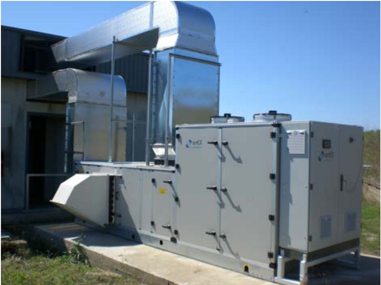
Figura 32. Installazione del roof-top e collegamento ai canali di mandata e ripresa aria (lato sx)
