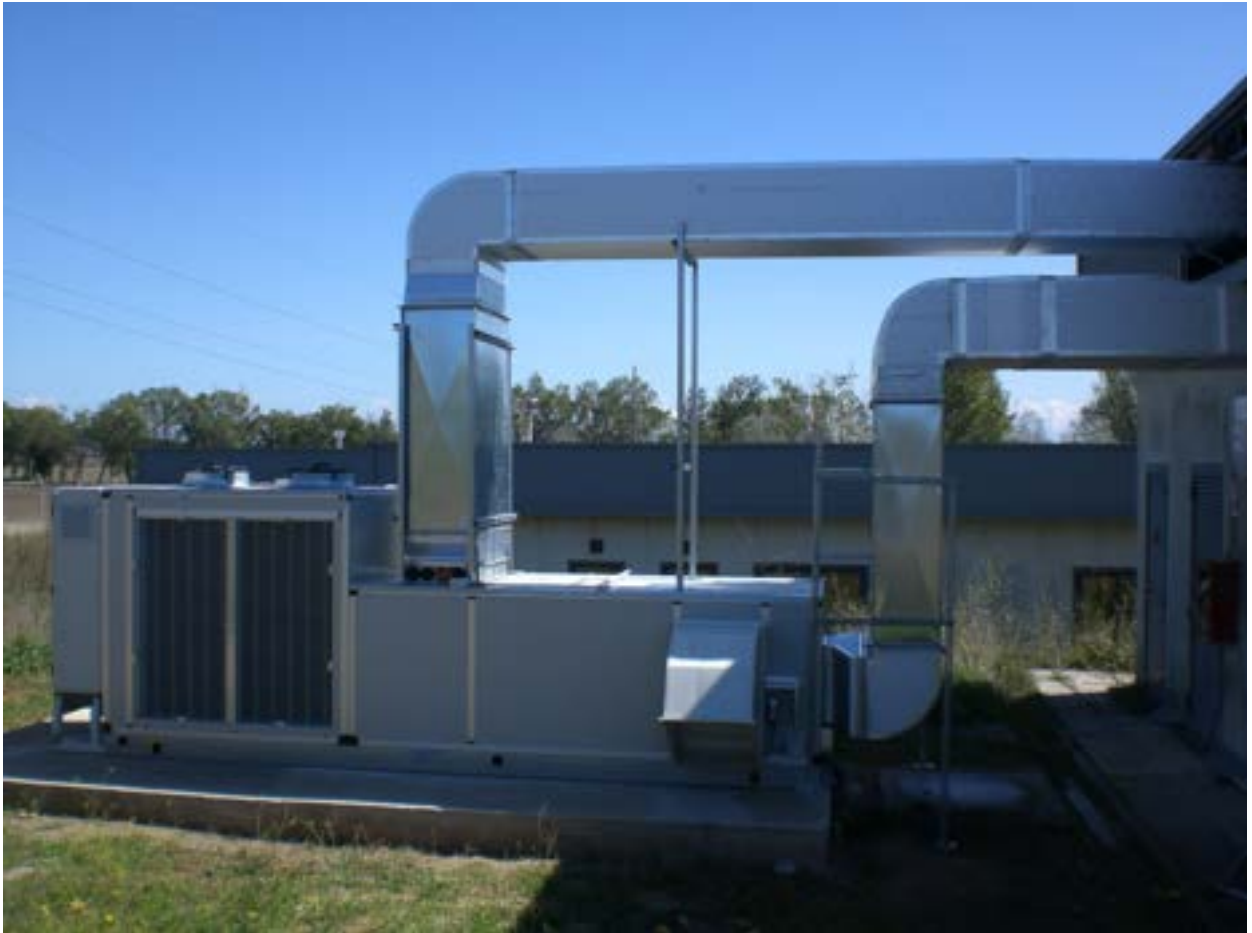
Figura 33. Installazione del roof-top e collegamento ai canali di mandata e ripresa aria (lato dx)
