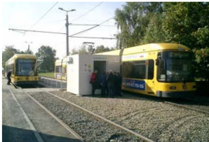
Figura 4.5 – Sistema tranviario abbinato ad un sistema di accumulo stazionario a supercondensatori nella città di Dresda, Germania. Accumulo su supercondensatori Maxwell Technologies ed elettronica di potenza Siemens.
