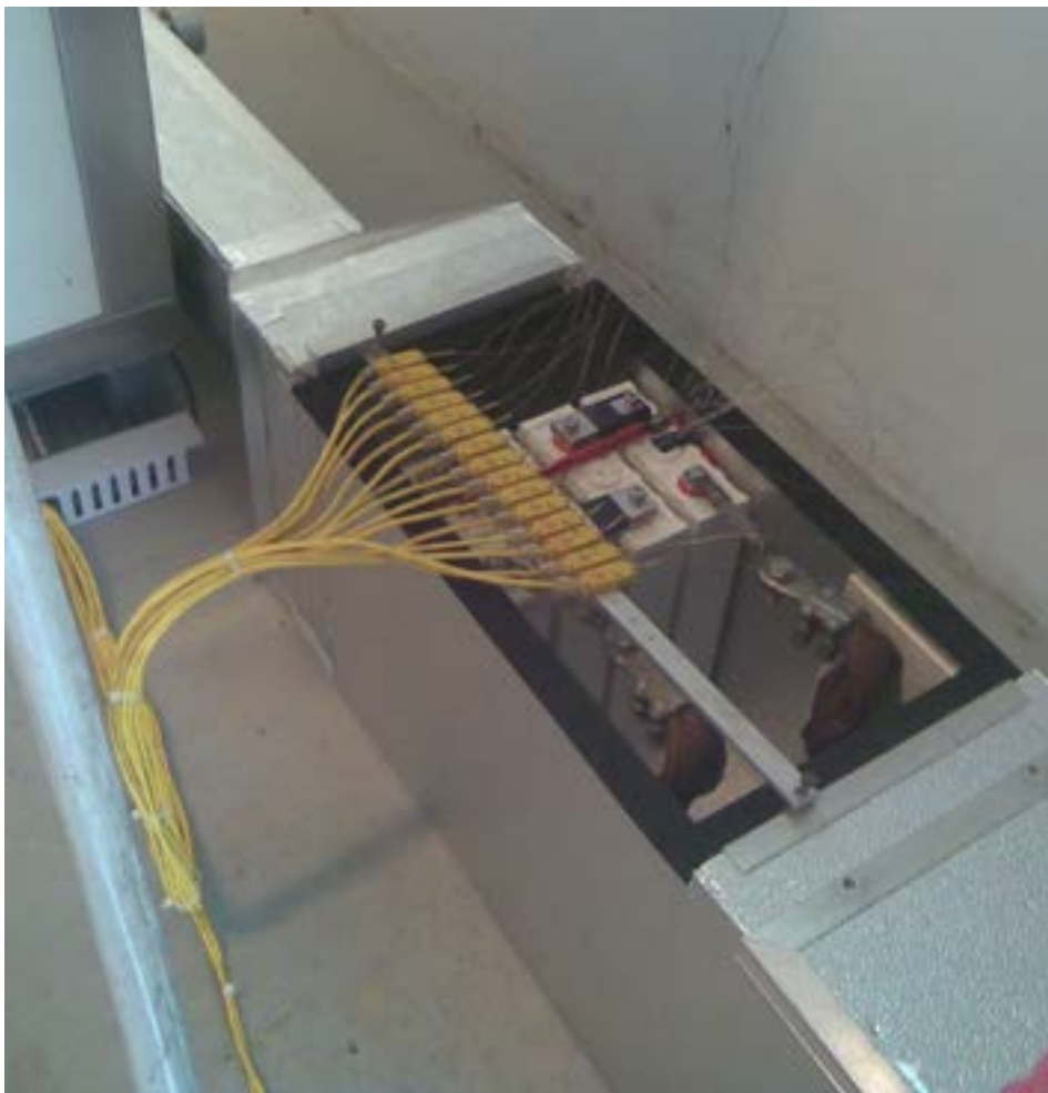
Fig. 22 – Disposizione e strumentazione delle batterie all’interno della sezione di prova
