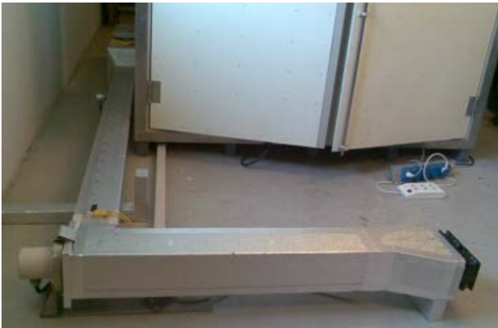
Fig. 20 – Realizzazione dell'impianto BA.CO
