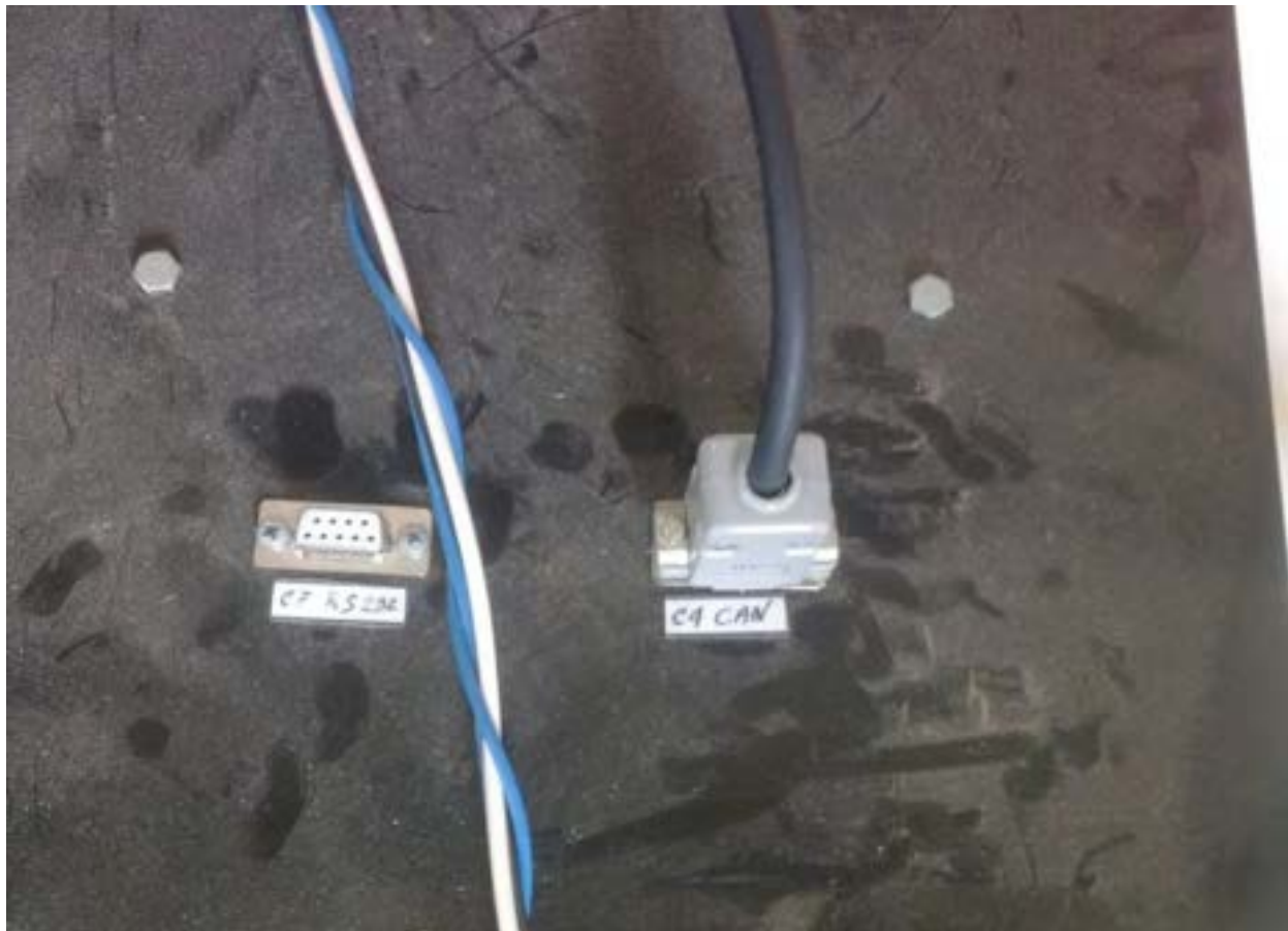
Figura 7. Particolare delle porte di comunicazione.
