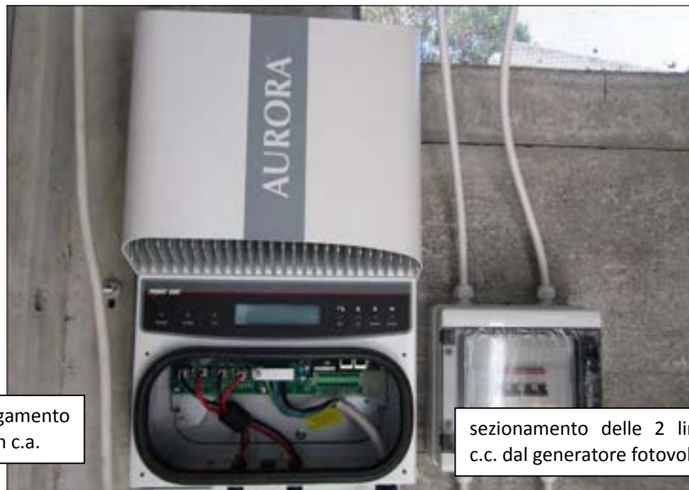
Figura 4. L'inverter utilizzato e le linee elettriche ad esso connesse
