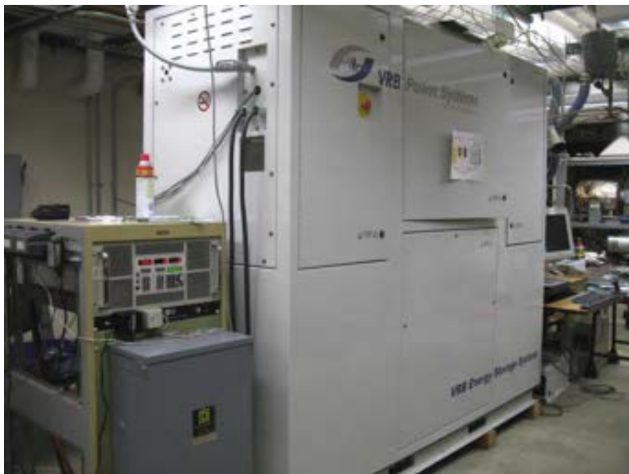
Figura 9. Batteria in prova nell'Università di Fairbanks
