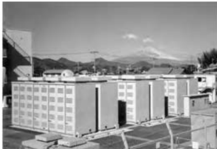
Figura 2. Sistema di accumulo Sodio/Zolfo NGK operativo a Ohito, Giappone, in a load-leveling mode (6MW/48 MWh). Questa batteria è una delle due più grandi batterie sodio/zolfo mai costruite ed è operativa dagli inizi del 1998 (Fonte: Courtesy of Tokyo Electric Power Ltd.)
