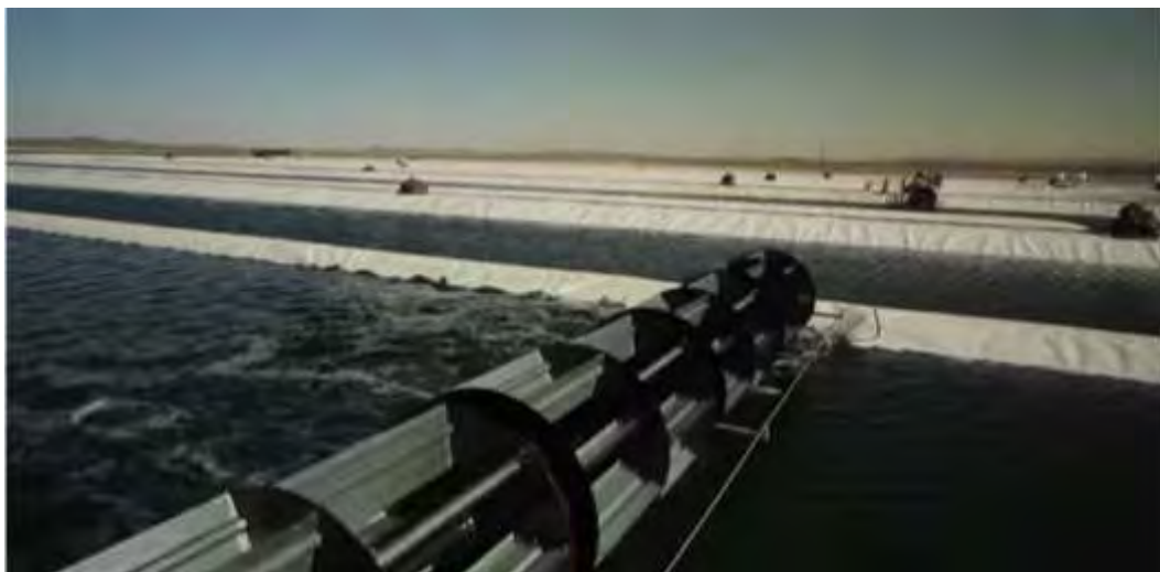
Figura 10. Sistema di agitazione dell'impianto della Sapphire Energy
