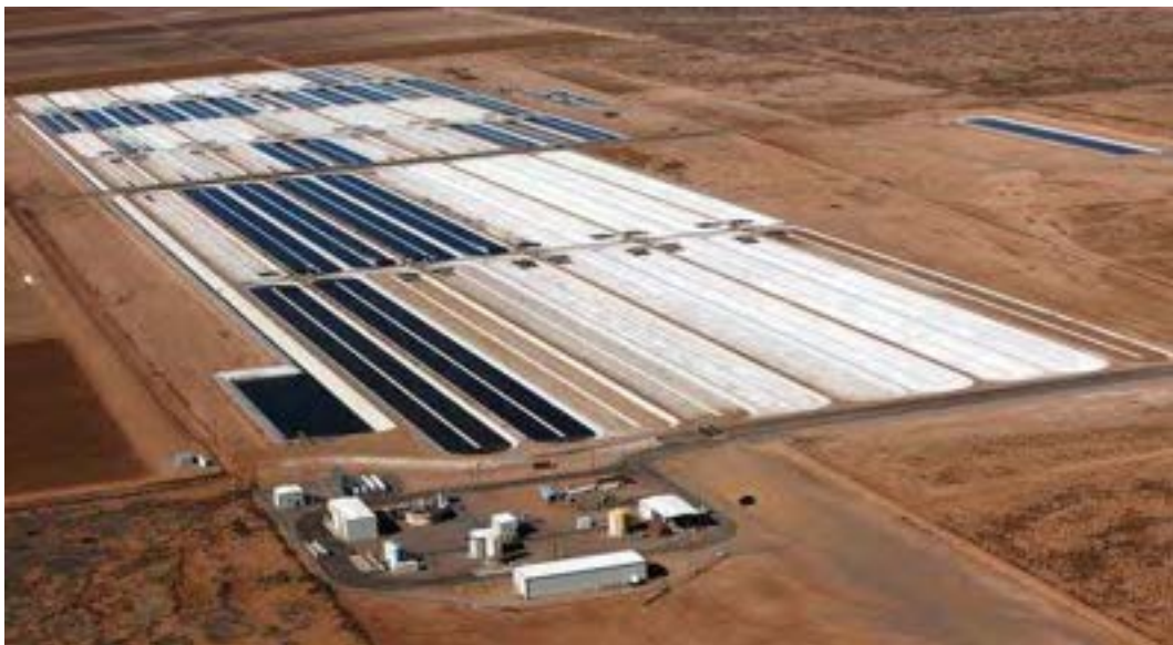
Figura 9. Panoramica dell'impianto della Sapphire Energy
