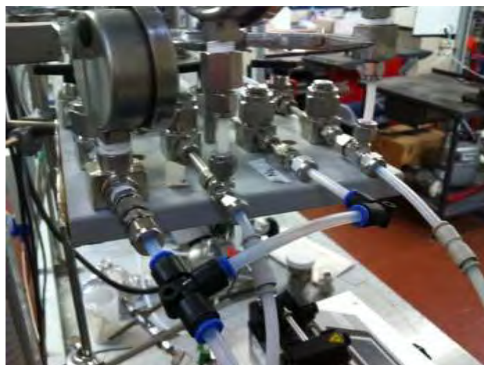
Figura 14. Dettaglio linea di alimentazione gas
