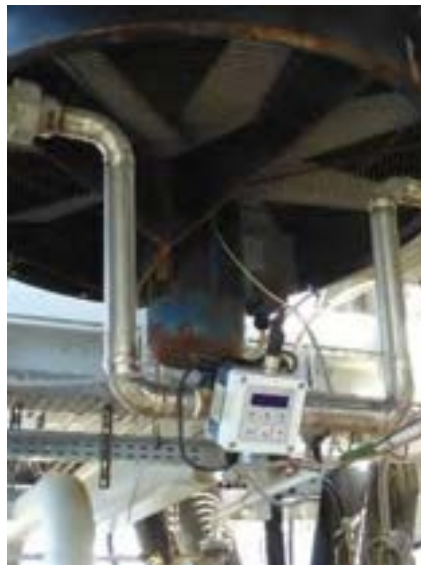
Figura 2.11. Misuratore di portata condense ad ultrasuoni
