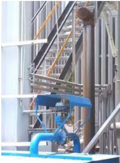
Figura 2.18. Valvola di riciclo aria (in basso) e nuovo vent
