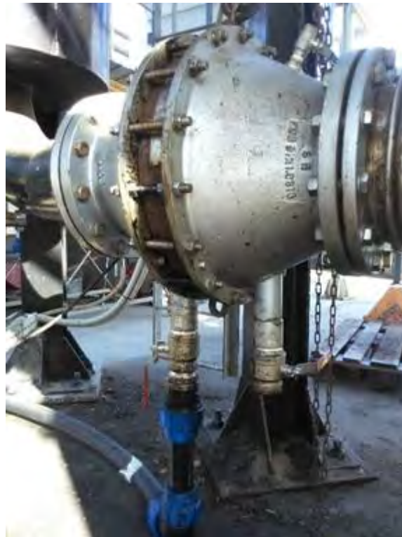
Figura 2.25. Bocchelli di spurgo della valvola rompifiamma
