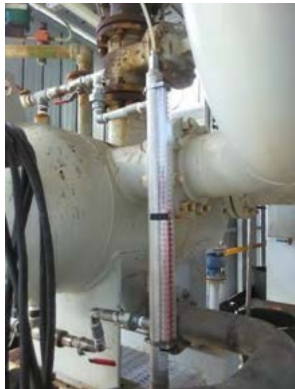
Figura 2.9. Indicatore di livello magnetico dello steam drum
