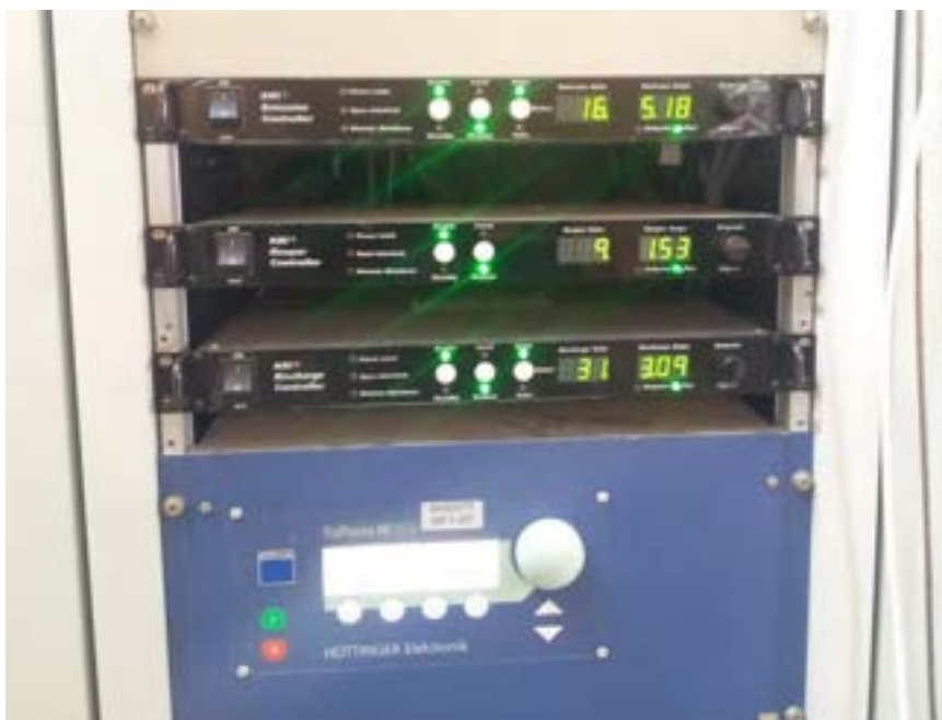
Figura 55. Alimentazione e controllo elettronico della sorgente KRI EH200/MHC1000: sistema d'innesco del neutralizzatore MHC1000 (Keeper Controller), alimentazione e controllo del neutralizzatore MHC1000 (Emission Controller) ed alimentazione e controllo del cannone ionico EH200 (Discharge Controller)
