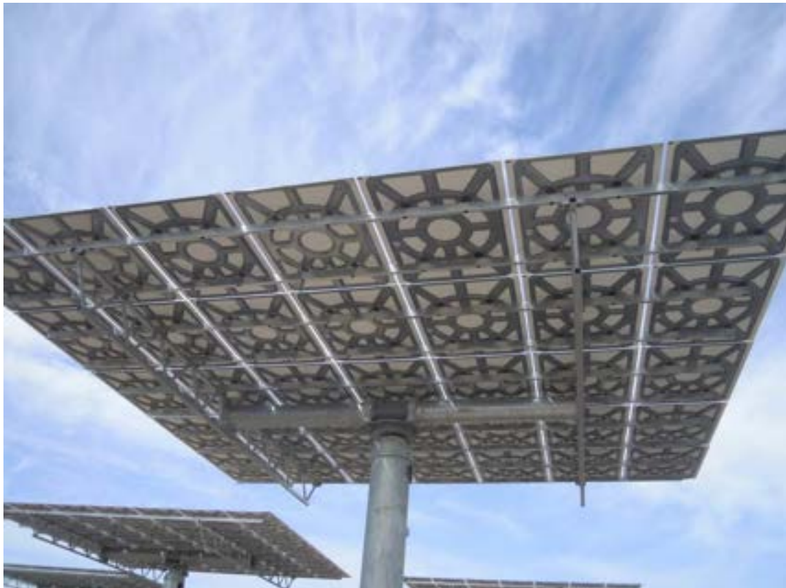
Figura 6: Eliostato: è costituito da 35 specchi piani
