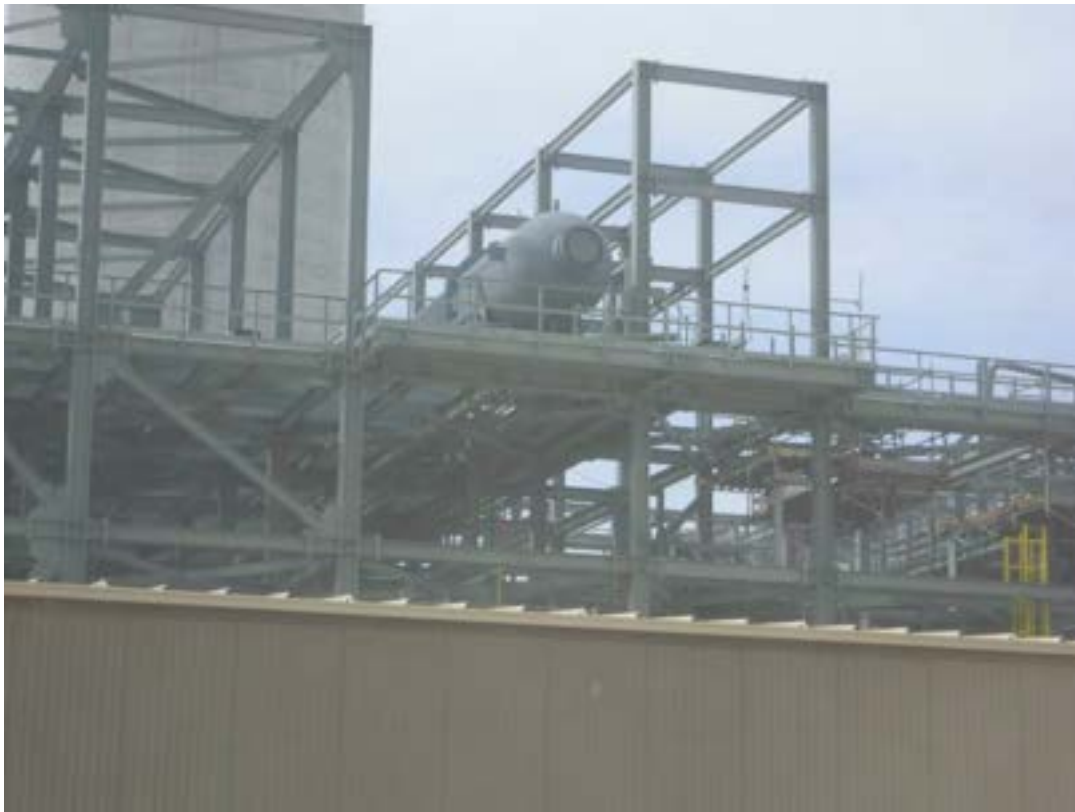
Figura 11: Particolare del Generatore di Vapore (Corpo Cilindrico)
