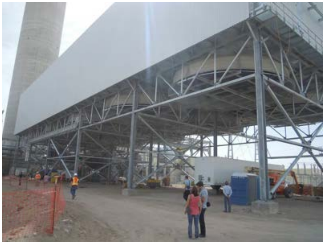
Figura 12: Sezione condensatore raffreddato a secco
