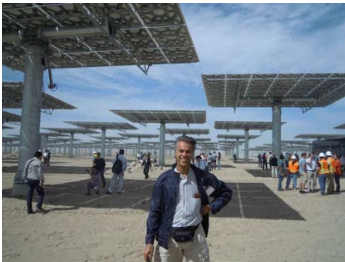
Figura 7: Veduta di parte del campo di eliostati
