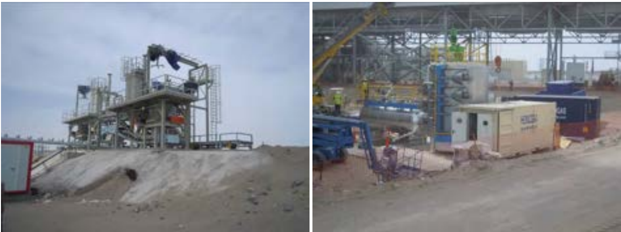
Figura 13: Frantumatore (a sinistra) e fusore (a destra) per la carica dei Sali
