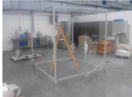
Montaggio della struttura di supporto
