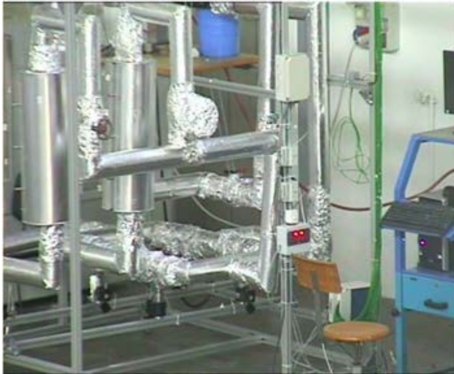
Figura 6 – Impianto realizzato in Casaccia
