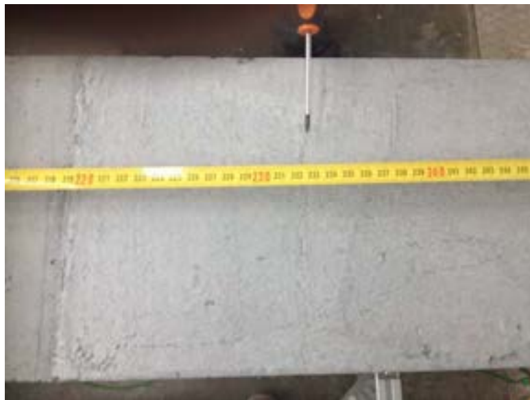
Figura 49: Modulo UNIPD-ITALCEMENTI, fessurazioni a circa 232 cm durante lo stazionario con set-point a 160°C.
