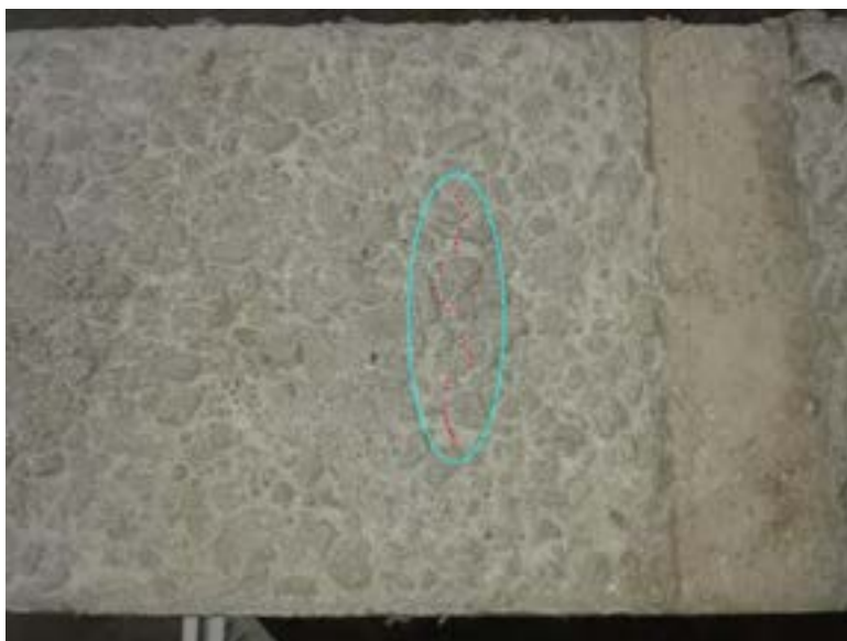
Figura 50: Modulo UNITN-CESTARO, fessurazioni a circa 70 cm dopo il ciclo di degasaggio.
