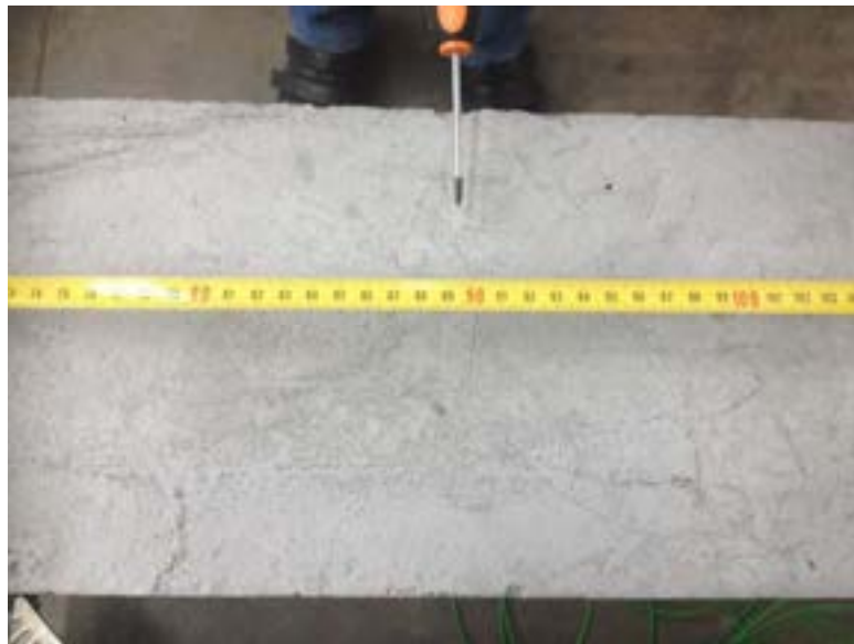
Figura 48: Modulo UNIPD-ITALCEMENTI, fessurazioni a circa 90 cm durante lo stazionario con set-point a 160°C.
