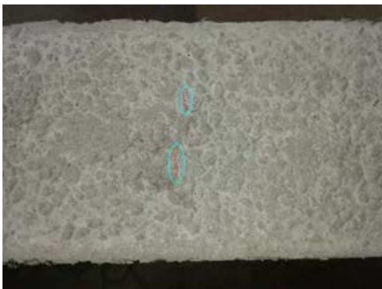
Figura 51: Modulo UNITN-CESTARO, fessurazioni a circa 1993 cm dopo il ciclo di degasaggio.
