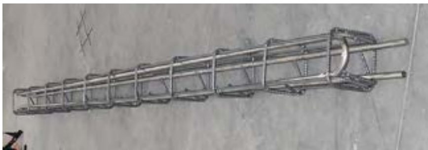
Fig. 11 Posizionamento del tubo di scambio all'interno della struttura di rinforzo.
