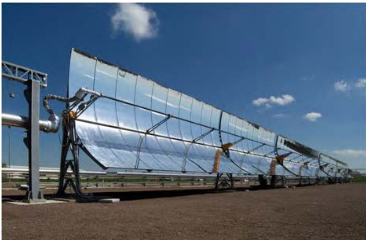
Figura 3.3 Rappresentazione di un tipico collettore parabolico lineare.
