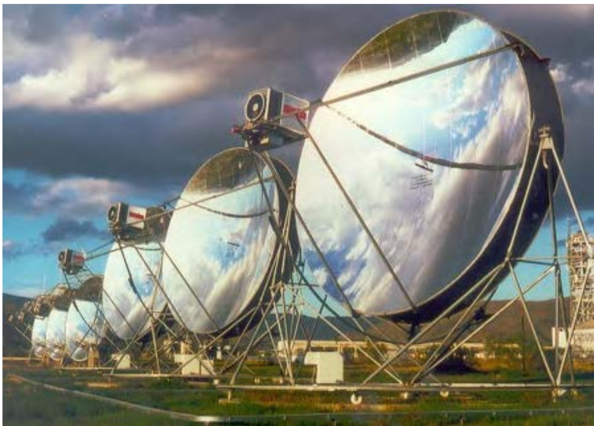
Figura 3.6 Rappresentazione di un collettore a concentrazione puntiforme.
