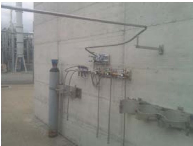
Figura 8 Installazione di un circuito valvole per la rampa gas di alimentazione CO
