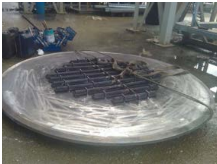
Figura 6 Revisione del piatto distributore del reattore SE-WGS
