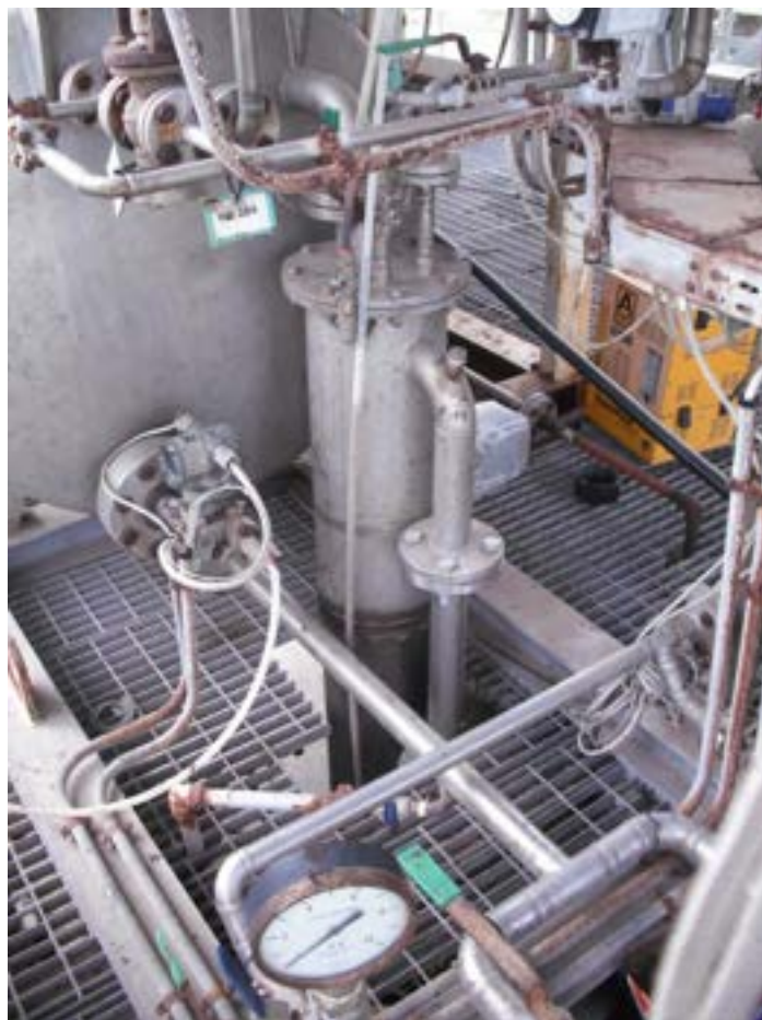
Figura 4. - Guardie idrauliche modificate
