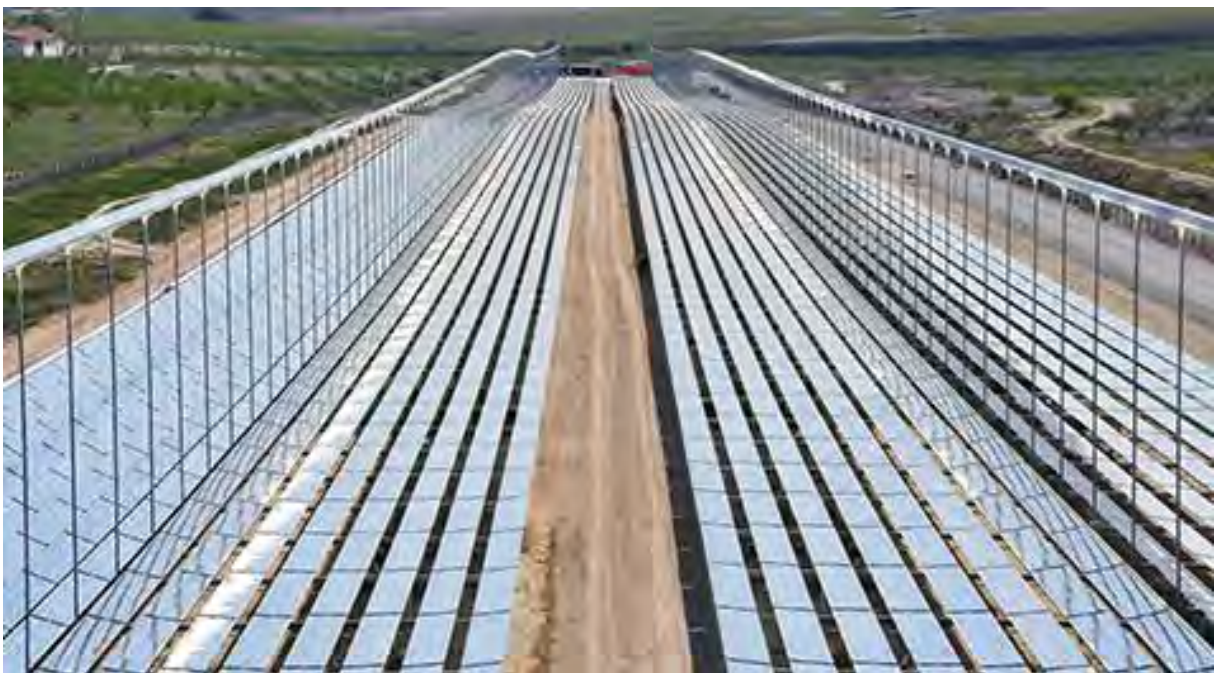
Figura 3.3 Rappresentazione schematica di un collettore lineare Fresnel.
