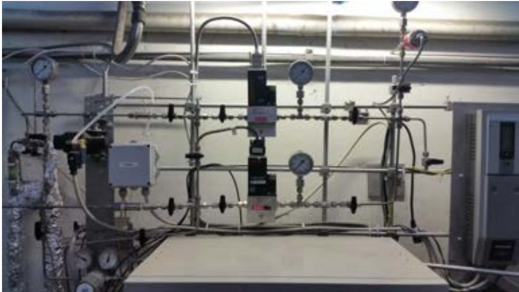
Figura 2.2: Zona di alimentazione gassosa dell'impianto Fischer-Tropsch.
