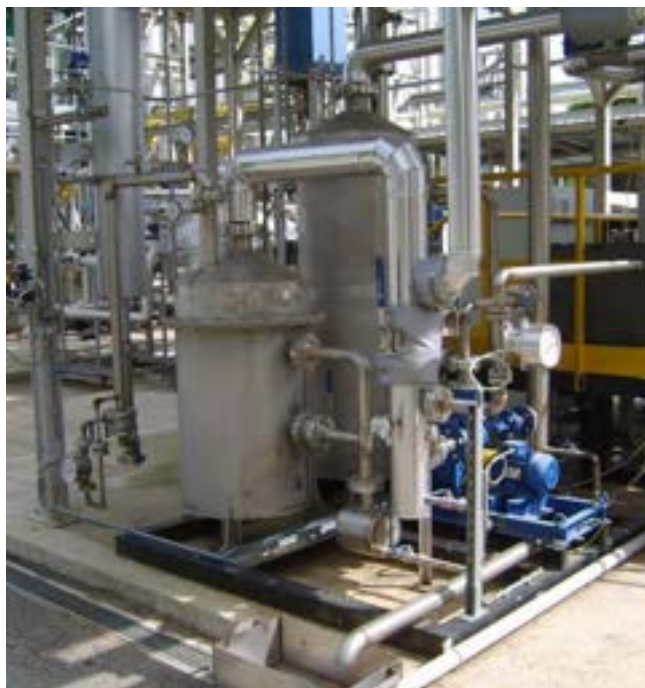
Figura 7 - VALCHIRIA - Sistema di raffreddamento.
