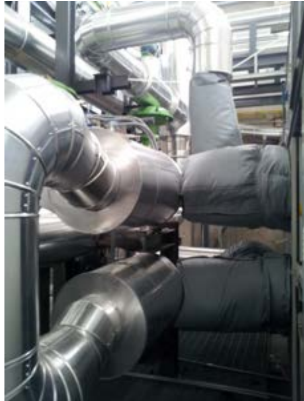
Figura 6. Tratto binato di piping in cui coesistono le coperture semirigide rimovibili e i materassini per i tratti in cui ingombri e/o geometrie sono particolarmente problematici.
