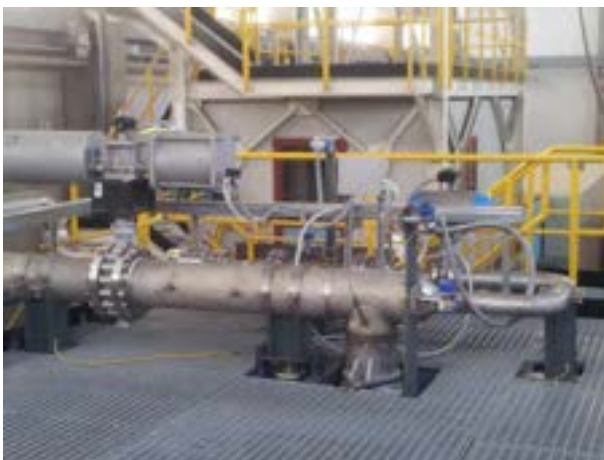
Figura 4 . alcune viste di dettaglio dei componenti di piping installati: giunto di espansione (in alto a sinistra), condotto binato “verso turbina” (in alto a destra), piping di interfacciamento vessel – turbina – vent (in basso a destra) e turbina – vessel –vent (in basso a destra).
