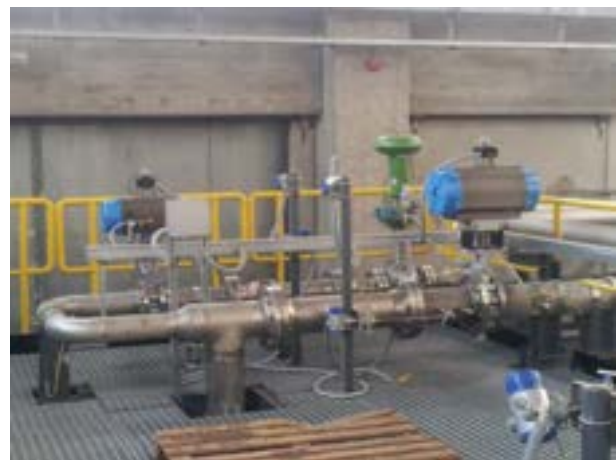
Figura 4 . alcune viste di dettaglio dei componenti di piping installati: giunto di espansione (in alto a sinistra), condotto binato “verso turbina” (in alto a destra), piping di interfacciamento vessel – turbina – vent (in basso a destra) e turbina – vessel –vent (in basso a destra).
