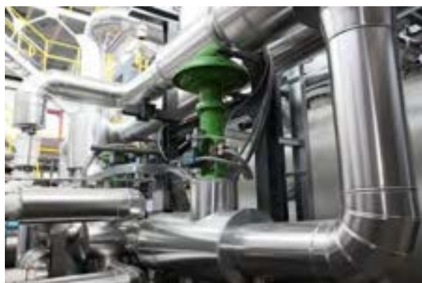
Figura 5. Alcune fasi delle lavorazioni di coibentazione del piping e dei componenti connessi. Si può notare la posa dei diversi strati di coibente: fibra ceramica avvolta da lana di roccia nei condotti ad alta temperatura.
