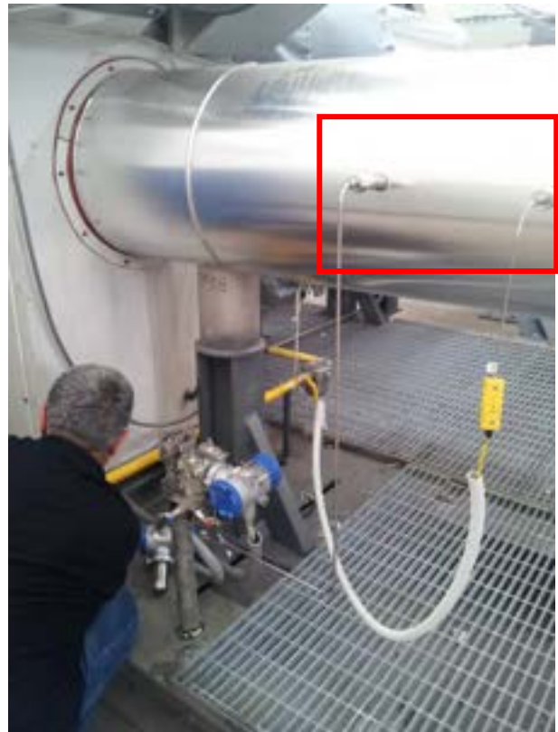
Figura 9. Sinistra: il filtro installato a protezione del sistema di alimentazione della \mu GT, a valle del dispositivo già esistente sulla rampa gas. Destra: installazione a bordo macchina di alcuni sensori di pressione e temperatura.
