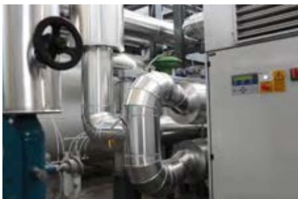
Figura 5. Alcune fasi delle lavorazioni di coibentazione del piping e dei componenti connessi. Si può notare la posa dei diversi strati di coibente: fibra ceramica avvolta da lana di roccia nei condotti ad alta temperatura.
