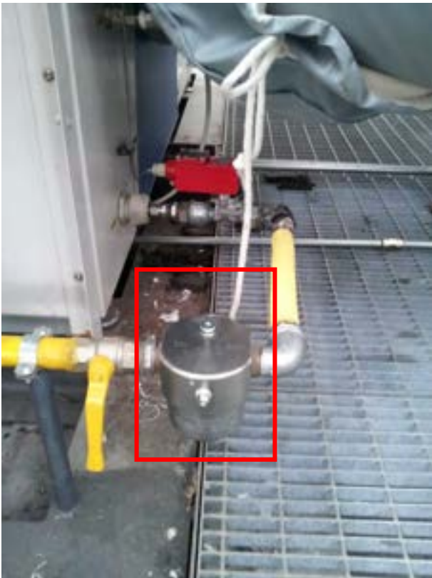
Figura 9. Sinistra: il filtro installato a protezione del sistema di alimentazione della \mu GT, a valle del dispositivo già esistente sulla rampa gas. Destra: installazione a bordo macchina di alcuni sensori di pressione e temperatura.
