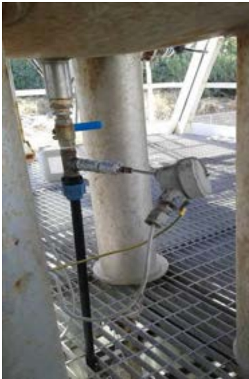
Figura 26, 27. Termocoppia sul solvente in uscita da reattore e Densimetro sul solvente in uscita da reattore
