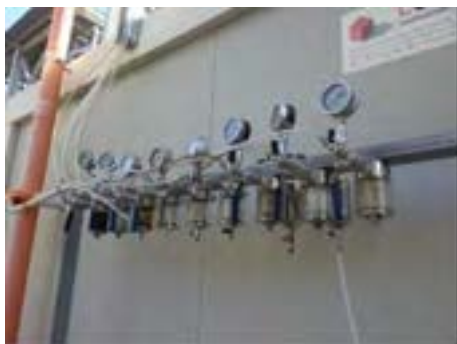
Figura 14, 15. Rastrelliere di raccordo per le linee di campionamento per sistema di analisi ABB (a sinistra) e per gascromatografo portatile (a destra)
