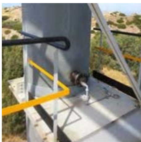
Figura 18, 19. Presa di campionamento DJ003 (torcia)
