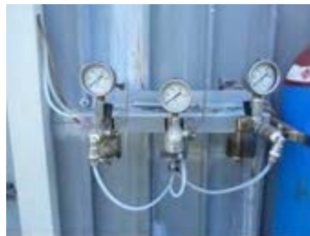
Figura 14, 15. Rastrelliere di raccordo per le linee di campionamento per sistema di analisi ABB (a sinistra) e per gascromatografo portatile (a destra)
