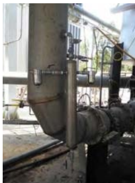
Figura 16, 17. Prese di campionamento DJ001 (uscita gassificatore) e DJ002 (uscita scrubber)
