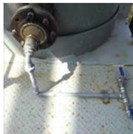
Figura 18, 19. Presa di campionamento DJ003 (torcia)
