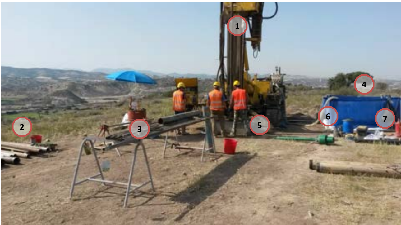
Figura 34: Area di cantiere per le perforazioni profonde
