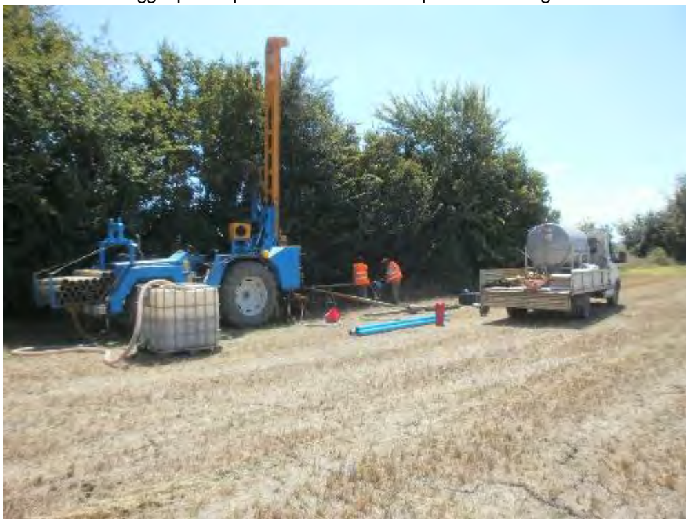
Figura 30: Area di cantiere perforazioni superficiali
