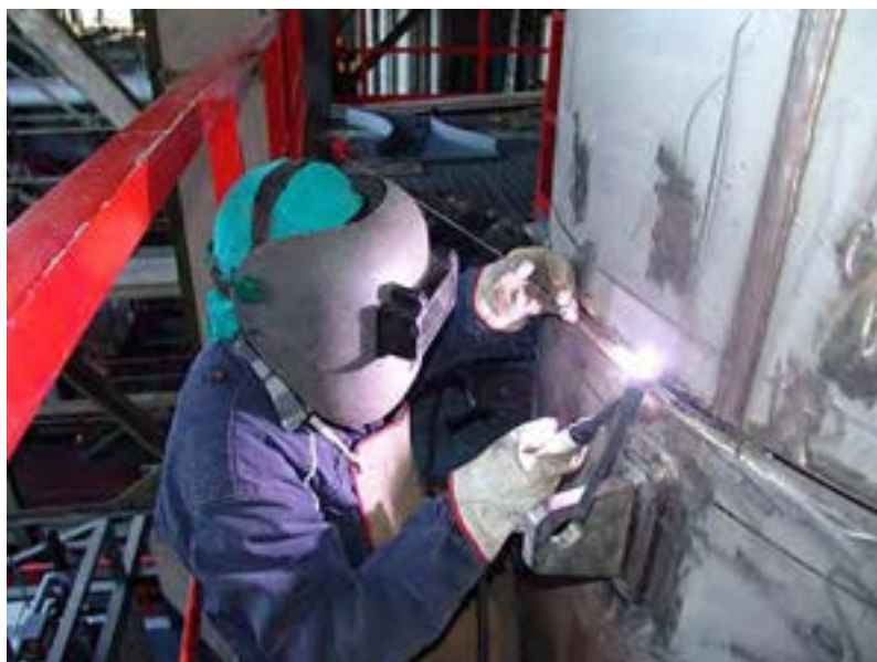
Figura 3 – Saldatura on site del dry-well di SPES-3
