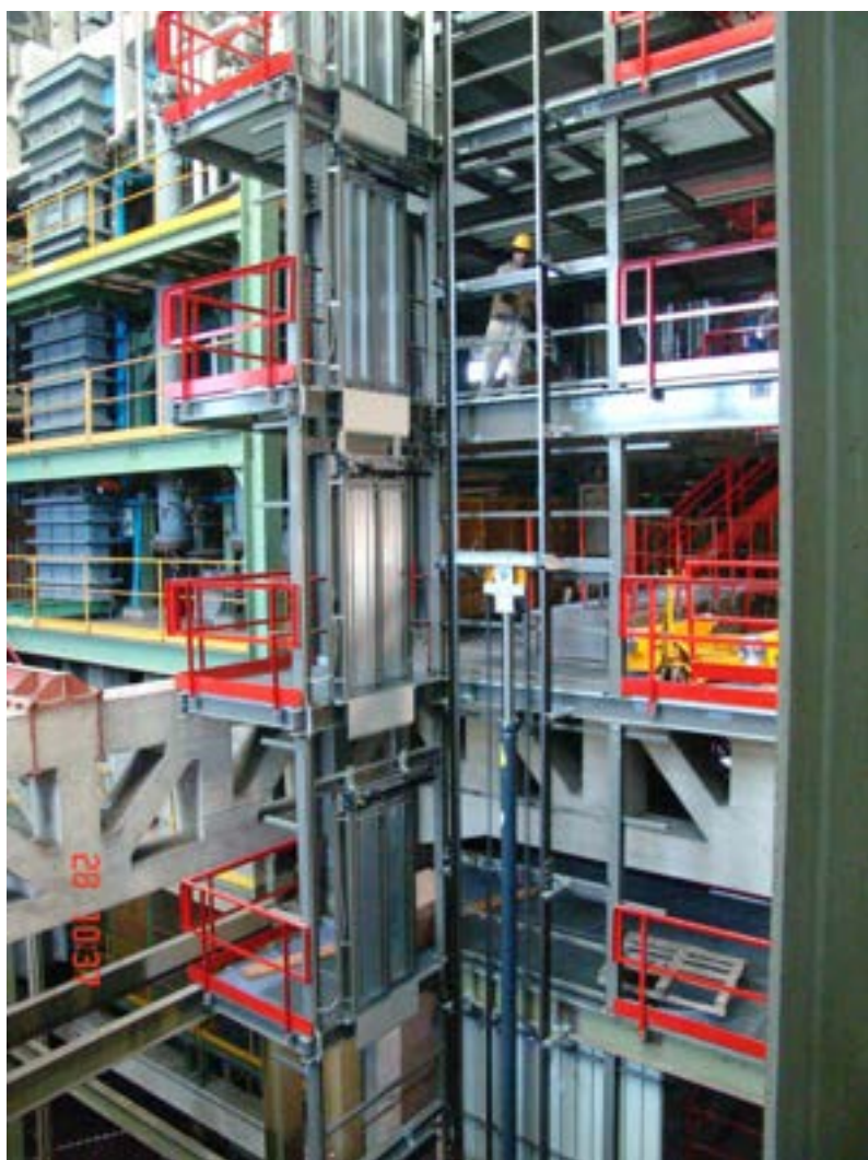
Figura 4 – Struttura portante SPES-3 (lato nord)
