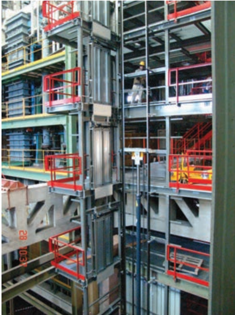
Fig. 8 - Struttura portante SPES-3
