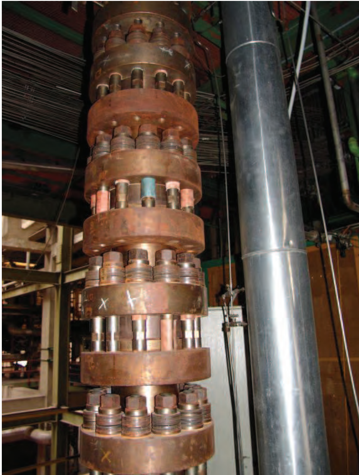
Figura 9 – Tratto flangiato del canale di potenza SPES-2
