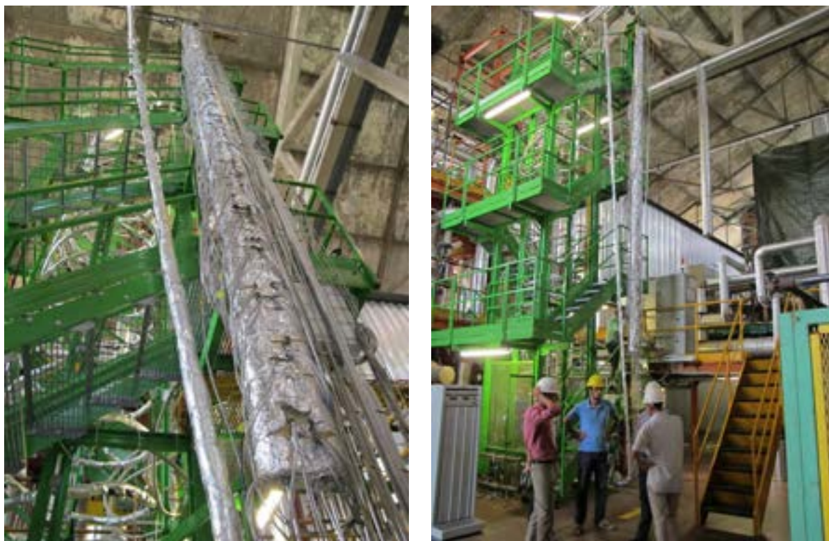
Figura 7 – Immagini della sezione di prova HERO-2 installata.
