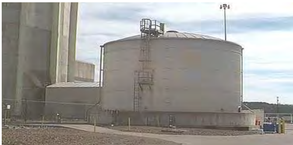
Figura 31 Serbatoio acqua di emergenza
