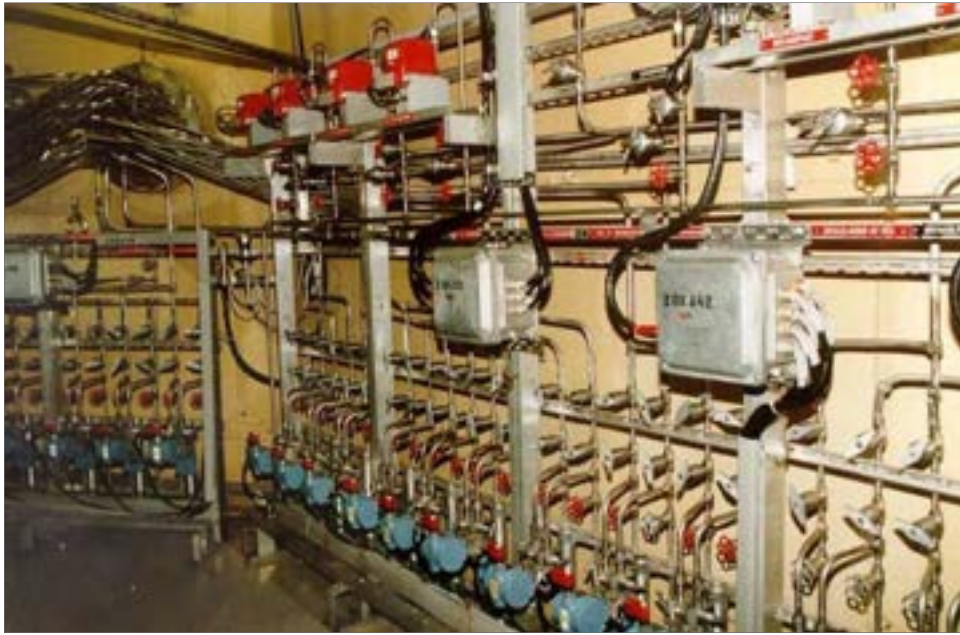
Figura 31 - Impulse lines per la misura di pressione a distanza.
