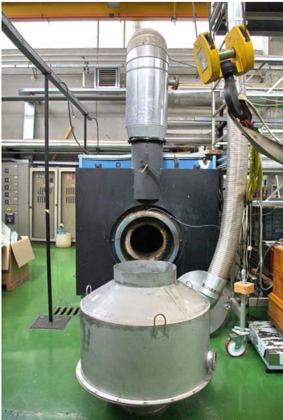
Figura 5. Scambiatore in fase di montaggio sulla caldaia
