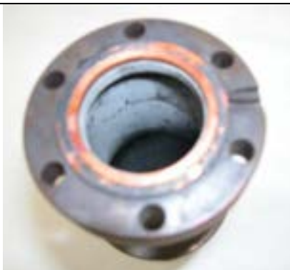
CsCl condensato all'interno del reattore
