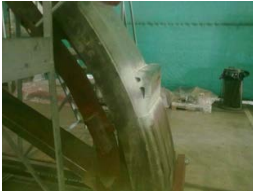
Figura 8: Supporto saldato sulla gamba curva
