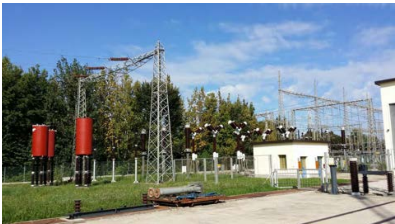
Figura 19. Una parte della sottostazione elettrica sfruttata per produrre i 41 kA di corrente necessari ad effettuare le prove di resistenza elettrodinamica del BPS.
