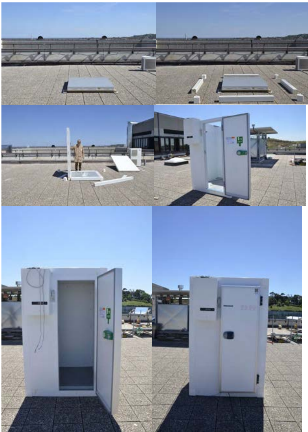
Figura 28 sequenza della costruzione delle celle frigorifere
