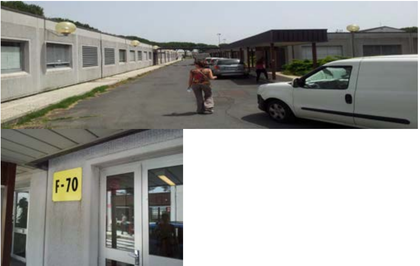
Figura 13: Edificio per uffici: facciata longitudinale e vista dell'ingresso.
