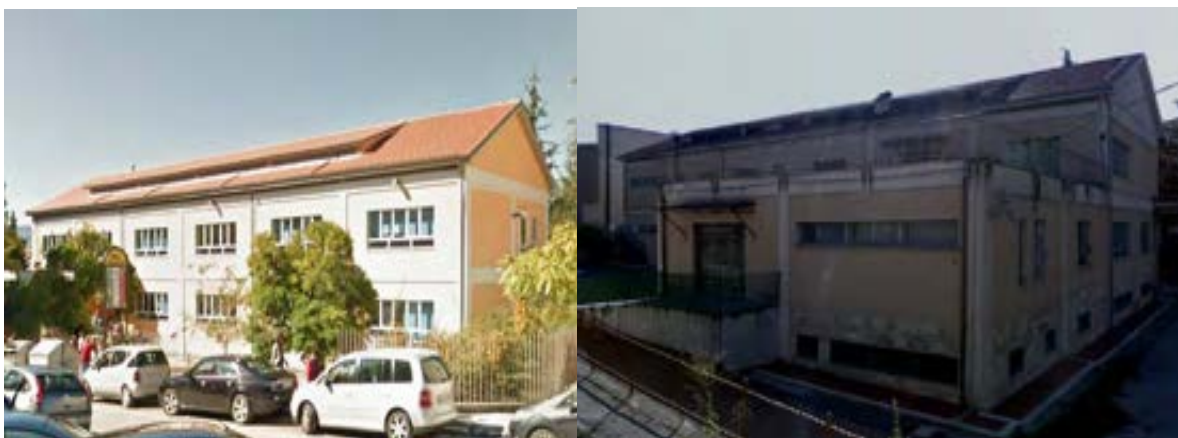
Figura 4: Scuola elementare, vista Ovest ed Est.
